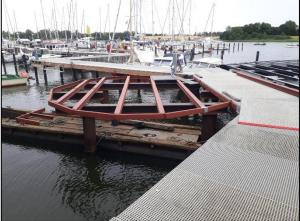
Höhe des Werftgeländes ans Ufer an. Parallel zum Steg sind Heckpfähle gerammt worden. Die Plattformen, auf denen das Bistro sowie das Hafenmeisterbüro errichtet werden sollen, sind im Nahbereich des Ufers entstanden. Sie sind ebenfalls auf Pfählen gegründet.
