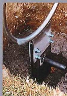
Für die Bodenmontage sind an an den beiden Ringen des Fahrradständers je zwei Bleche angeschweißt, zwischen die ein 200 mm breiter und 500 mm tiefer Flachstahl in 20 mm Stärke verschraubt wird.
