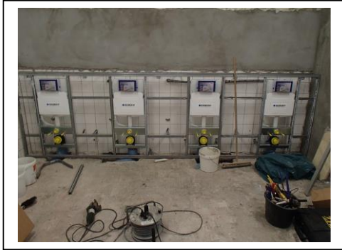
02.08.2016 Fliesen entfernen und verputzen
