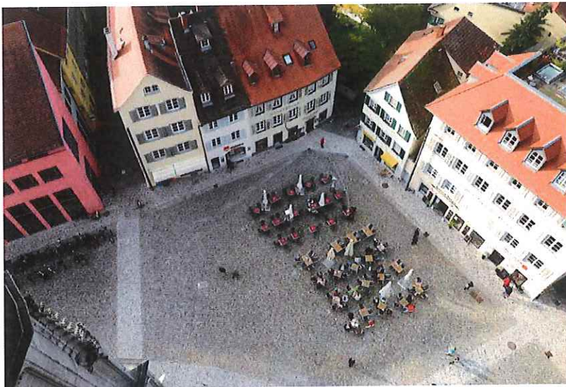
Bild 6 Blick vom Münsterturm auf die fertiggestellten Wegeläufe (geschliffen)
