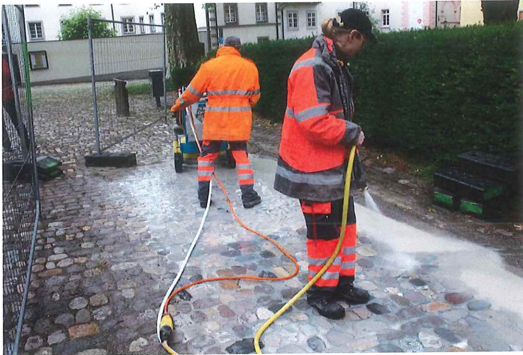
Bild 3 Gewerk 2 – Pflaster nass schleifen
