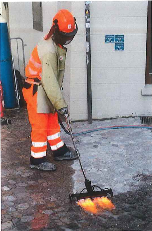
Bild 5 – Geschliffene Pflasteroberfläche abflammen – zur Wiederherstellung von Rutschfestigkeit und natürliche Steinfärbung
