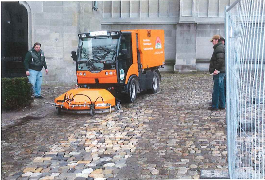
Bild 1 Gewerk 1 Sandfugen ausräumen – Wasserhochdruckstrahlen + Absaugen
