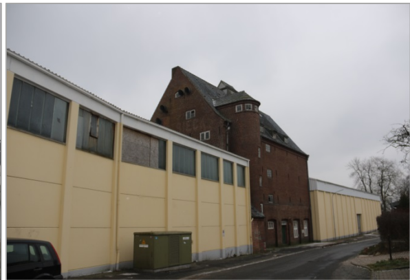
Foto 2: Rückwärtige Ansicht von Hallen und altem Speicher vom Bahnhofsweg aus gesehen.
