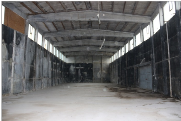
Foto 5: Innenraum der nördlichen Halle.
