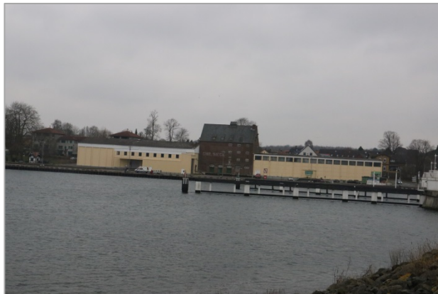
Foto 1: Gebäudekomplex von der Schleibrücke aus gesehen.
