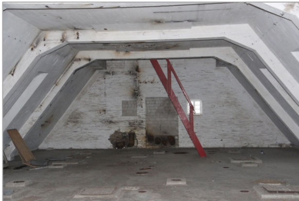
Foto 7: Zweitoberste Ebene im Dachbereich des alten Speichers
