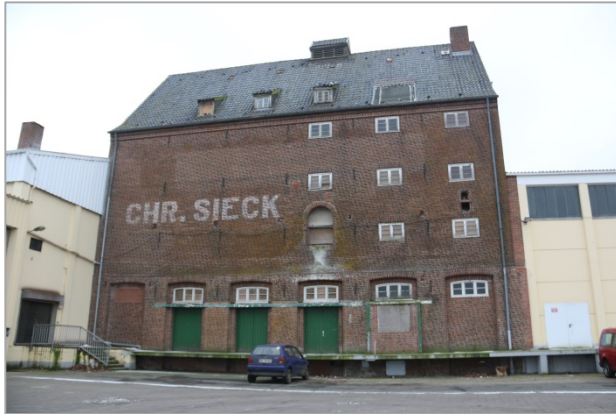
Foto 3: Ostfassade des alten Speichers.
