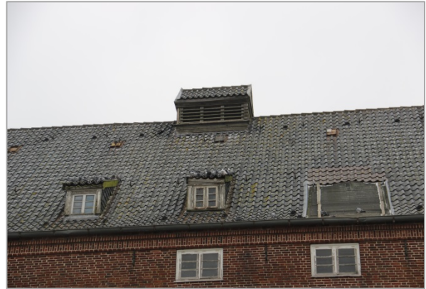
Foto 4: Detailaufnahme Dachbereich mit Gauben.
