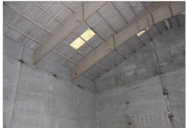
Foto 6: Dachkonstruktion der südlichen Halle
