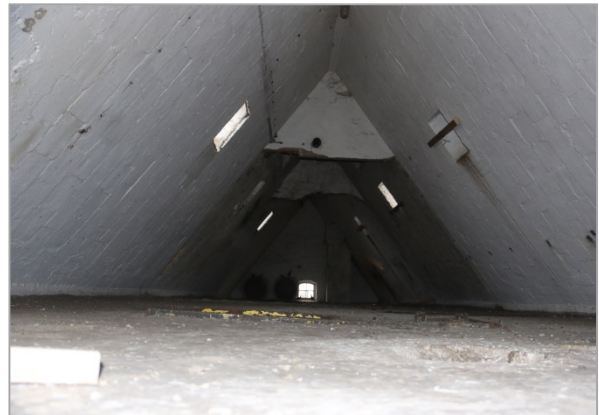
Foto 8: Oberste Ebene im Dachbereich des alten Speichers
