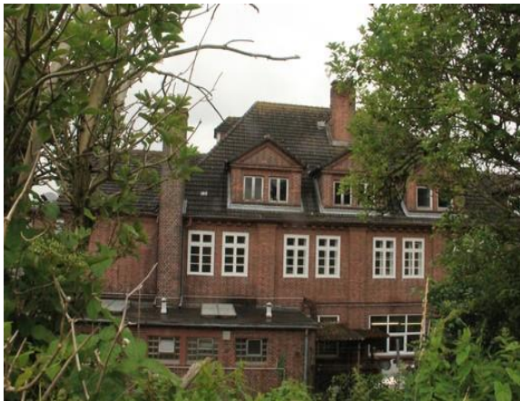
Foto 5: Hausmeistergebäude „Cremilk“ mit zwei Kaminen.
