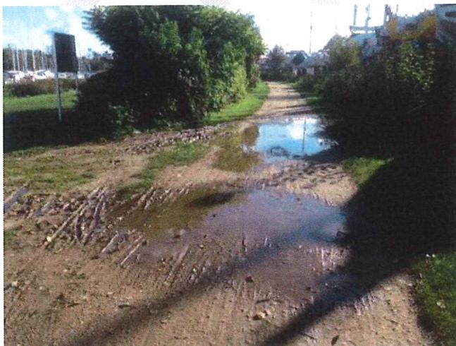
Der Fußweg von Anker bis Grauhöft erfolgt über einen mit wasserbindendem Material versehenen Weg der zurzeit das Wasser nicht mehr aufnimmt und nach Regenfällen zu Fuß nicht mehr zu benutzen ist. Die Fußgänger müssen dann über die Rasenfläche parallel zur Schlei ausweichen
