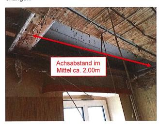
Vorgefundene Konstruktion: Dabei wurde ersichtlich, dass die tragenden Balkenquerschnitte synchron zu den Dachstuhlgebinden in einem Achsabstand von ca. 2,00m (i.M.) verlaufen. Von unten wurden die Deckenbalken mit einer Holzbrettschalung versehen, auf der ein Reetputz aufgebracht ist. Füllungen in den Zwischenräumen (Dämmung und/oder Schlacke etc.) sind nicht vorhanden. Den oberseitigen Deckenabschluss zum Dachraum bildet ebenfalls eine Holzbrettschalung.
