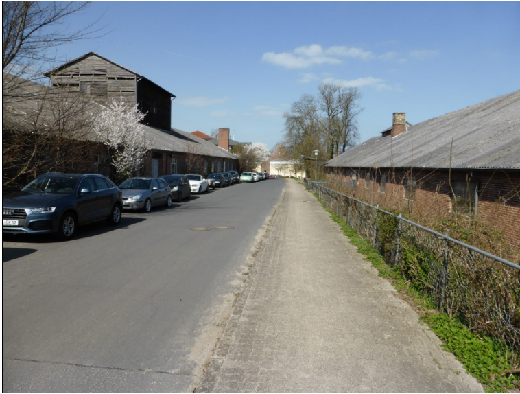
Abb. 5: Leerstehende Gewerbehallen beidseitig der Königsberger Straße
