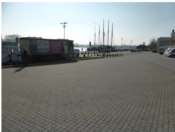
Abb. 8: Nördlicher versiegelter Bereich mit Bahnanlage und Straßen
