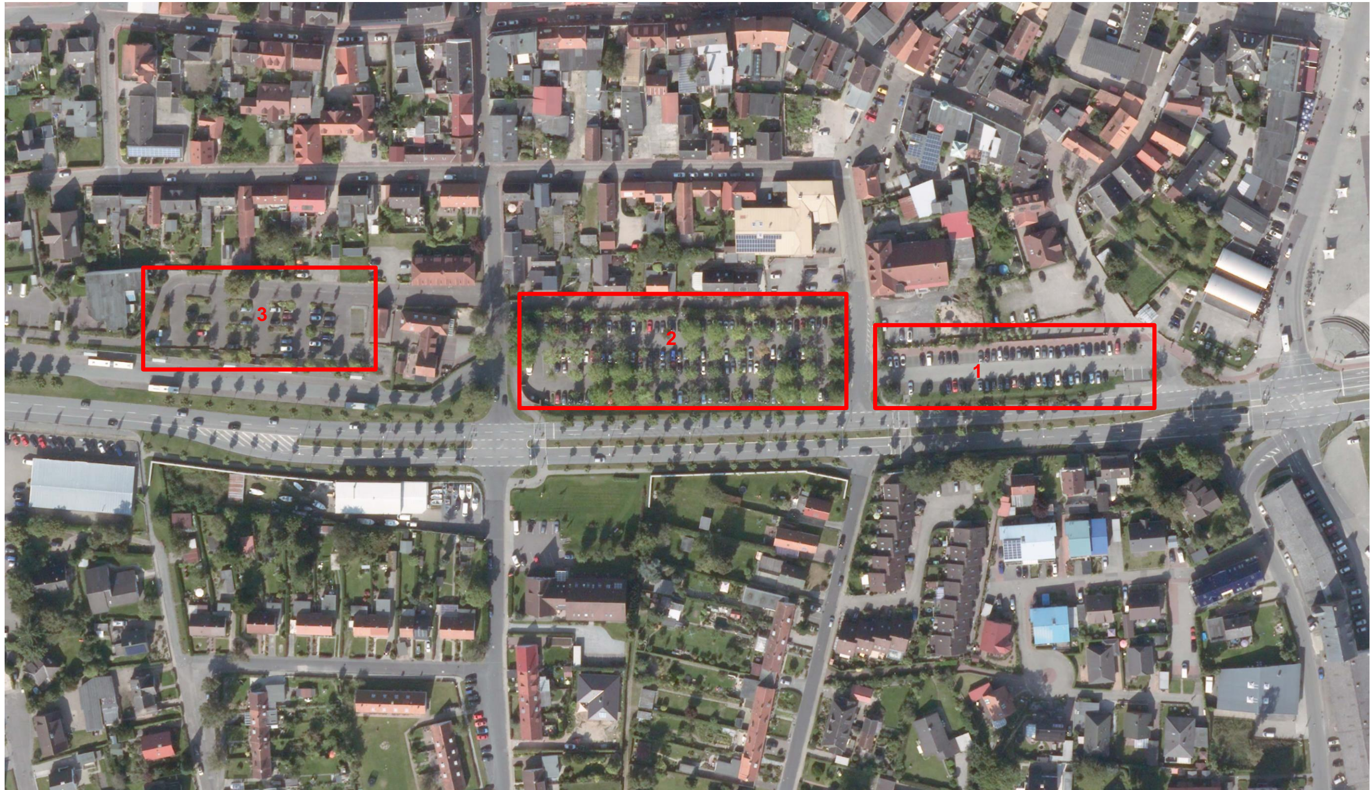
Luftbild der 3 Parkplätze entlang der B 201
