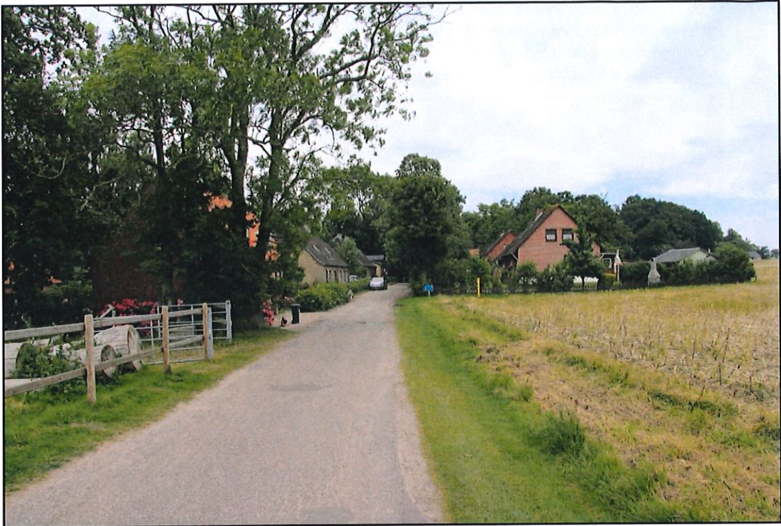
Blick nach Nordosten
