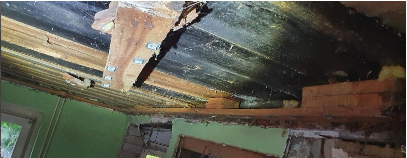
Foto 17 - Sichtbare Deckenbalken in der rechten WE
