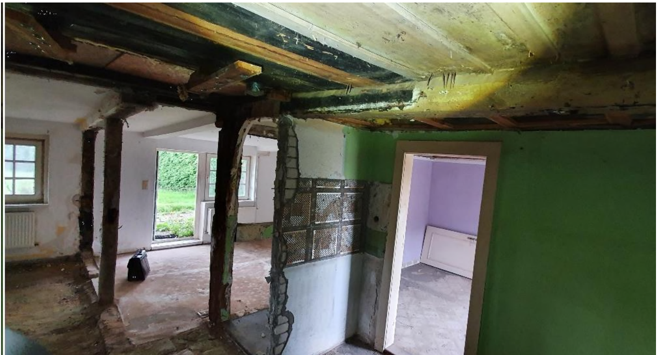
Foto 4- Blick in den Raum entfernte Innenwände
