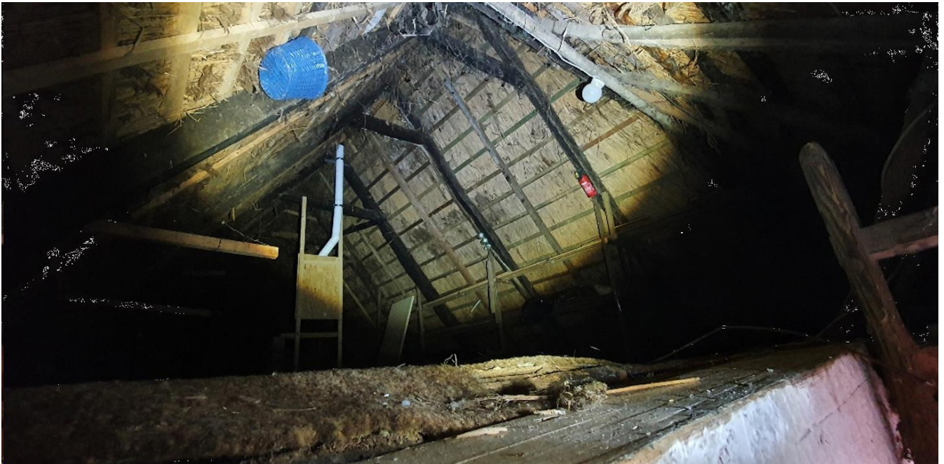
Foto 20- Blick in den Dachraum
